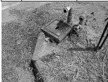
B 富岡市黒川 北部幹線水路
