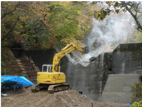
図2. 全国初、防災と溪流環境復元のための治山ダム中央部撤去（2009年実施）
