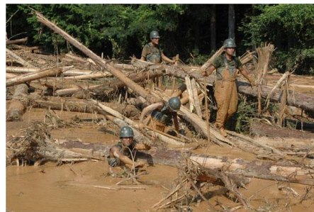
図4.佐用町における土石流災害発生後の復旧作業風景
