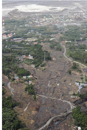
図2.大島の土石流災害
