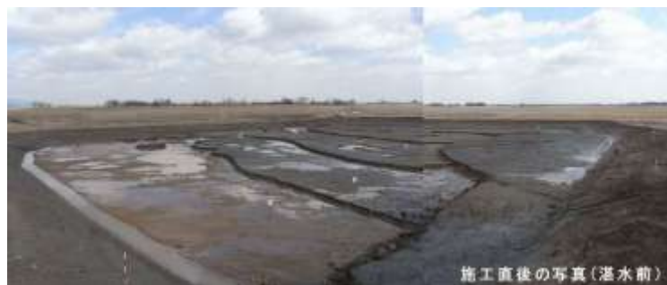
写-5 湿地再生地掘削地
