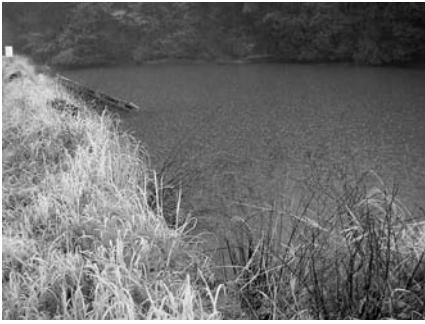
KA03 入木屋溜池
