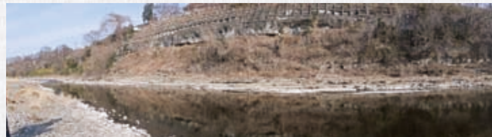
図2 鎚川左岸の露頭全景
