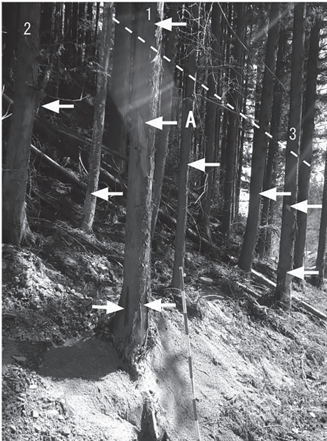
図8. 地点3, 琴木沢第2堰堤から見たヒノキの打痕 (2022.4.9撮影).
