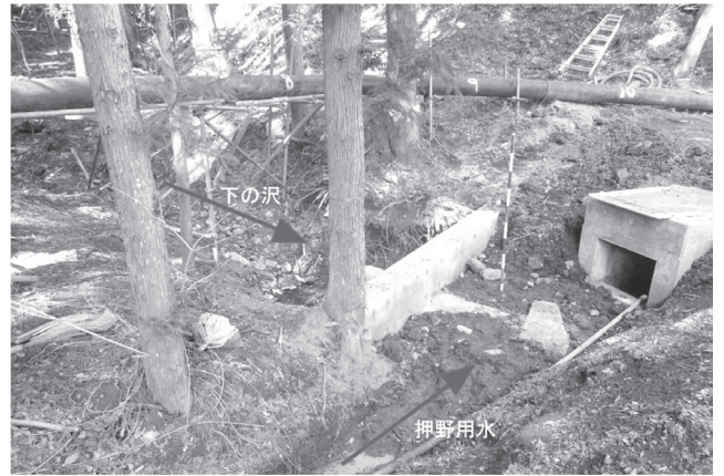
図9. 地点4, 下の沢と押野用水の合流点の土石流跡(2022.4.9撮影).
