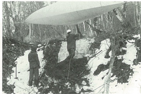
裏打ち布の上から硬化剤を吹き付けている
