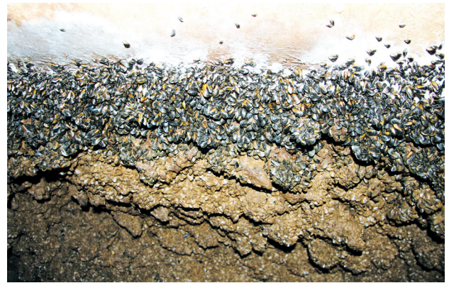
大塩湖導水管内部に付着したカワヒバリガイ
