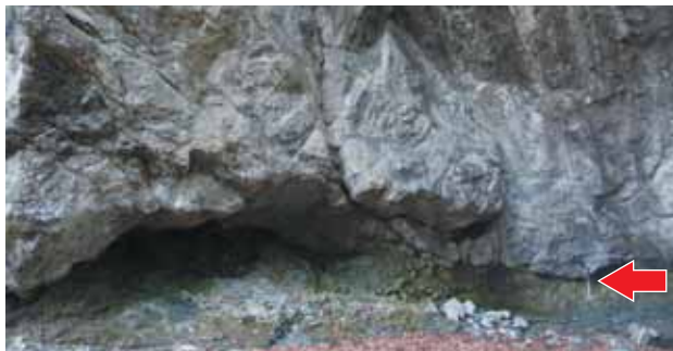
跡倉橋下流の左岸にみられるフェンスター
