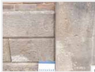
図1 富岡製糸場西繭倉庫の基礎となっている砂岩
