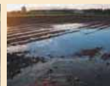
写真3 その後溜まった雨水
