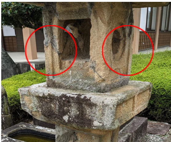
図1 補強されている多胡石で作られた灯籠
